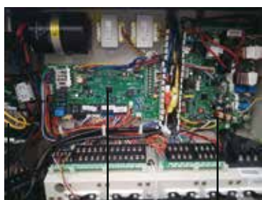
PCB A Tableau de commande principal du module hydraulique PCB B
