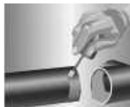
APPLICATION du polymère de soudure
