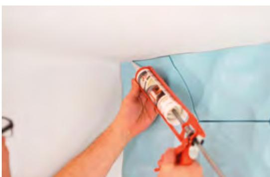
La parte posterior de los ARSTYL® WALL TILES para pared vienen con irregularidades y huecos. Si se va a instalar un elemento con una cara seccionada visible, esta se puede aplanar con ADEFIX® PLUS y ADEFIX®. Procure que el masillado de las superficies se haga únicamente con ADEFIX®.
