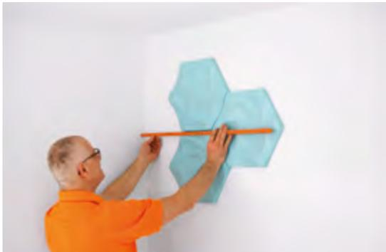
Medir la pared y determinar la posición de los paneles. Ajustar la línea de colocación inferior utilizando un nivel de burbuja.
