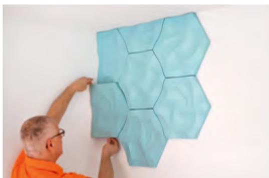
Para las zonas de unión entre techo y pared utilizar adhesivo de montaje ADEFIX®.
