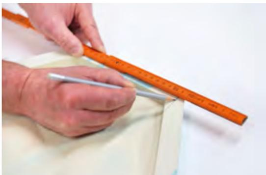
Medir el tamaño de los ARSTYL® WALL TILES que han de colocarse en las zonas de unión con las paredes laterales y el techo y trasladar la medida al dorso.
