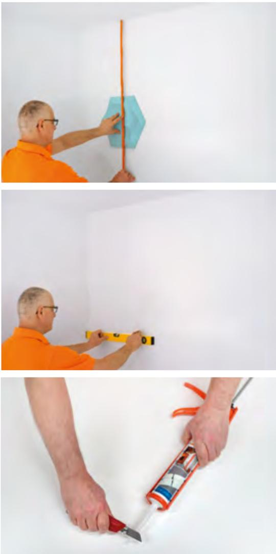
Medir la pared y determinar la posición de cada ARSTYL® WALL TILES.
