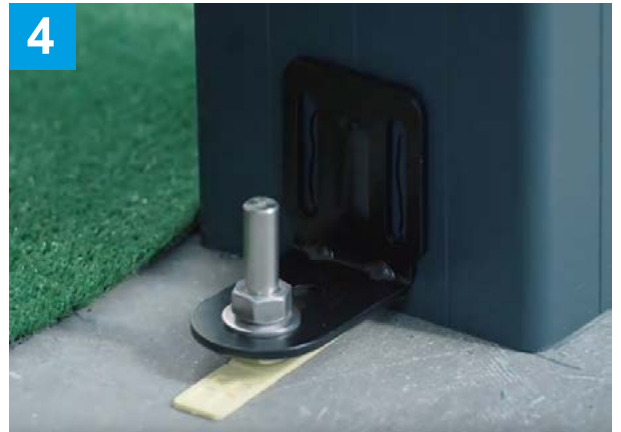
4 Placer une cale de 2mm sous le gond bas puis tracer les trous de fixation.
