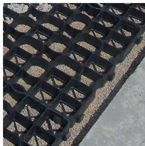
Les dalles doivent être posées à 5 cm du bordurage (joint de dilatation) afin d'éviter leur soulèvement.
