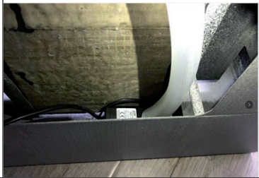
Conecte la manguera a la parte trasera de la unidad con la bomba.
