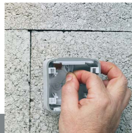
1/ Prédécoupe de l'embout en tirant sur l'opercule.
