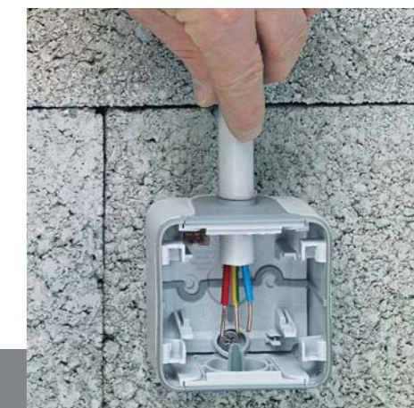
3/ La membrane de l'embout rattrape le désaxage éventuel du tube et assure l'IP 55 de l'installation.
