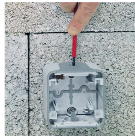
1/ Perforation de l'embout à l'aide d'un tournevis.
