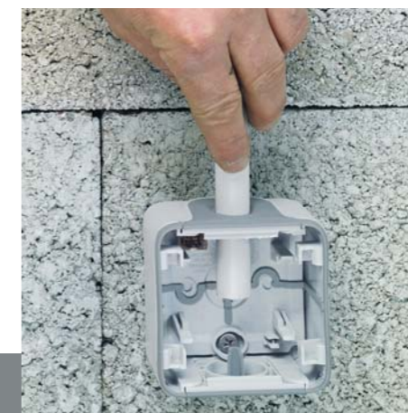
2/ Passage du tube dans l'embout.
