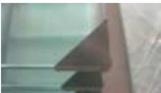
Bringen Sie die unteren Tür- & Magnetdichtungen entsprechend der Abbildung an. Passen Sie die Dichtungen so an, dass zwischen Rundprofil und unterer Dichtung keine Lücke entsteht, schneiden Sie die Dichtung ggf. zu. Lassen Sie die Dichtung zum Einstieg hin überstehen, die Magnetleisten werden von oben auf „stoß „ gesenkt
