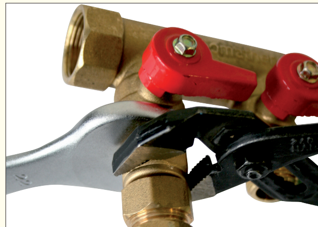
Contre-serrage d'un raccord sur le manchon à l'aide d'une clé 6 pans et d'une clé plate.
