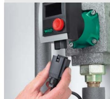
Le connecteur Wilo peut être raccordé au circulateur.
