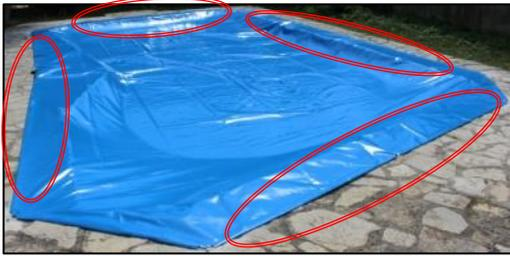
6 - Sur les parties droites, marquer, percer idem 2a §3 et 4 et insérer les pitons douilles
