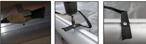
9 - Insérer les 3 inserts par la face inférieure de la couverture
