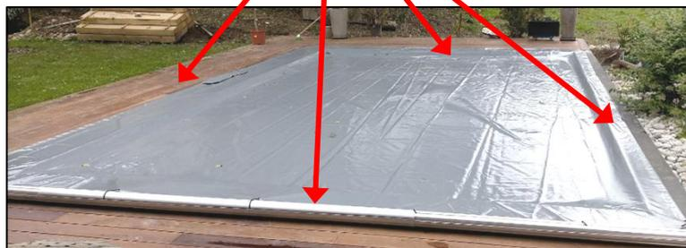
5 - Si besoin, actionner de nouveau le cliquet et mettre en tension la corde plus fermement.
