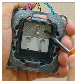
5. Serrer les 3 vis pour réaliser les connexions
