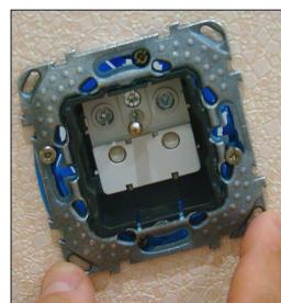
6. Dévisser légèrement les 2 vis de la boîte d'encastrement pour permettre le passage des 2 têtes de vis, mettre à niveau et fixer la prise
