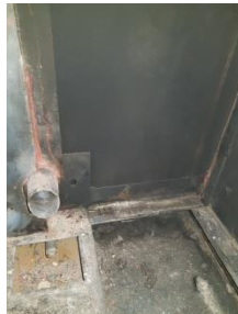
LIMPIAR PASO HUMOS
