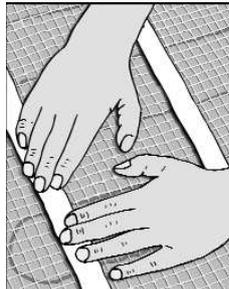
Vous devez noter sur la fiche de garantie la résistance ohmique ainsi que la valeur d'isolement relevée avant et après la pose du revêtement et avant la 1<sup>ère</sup> mise en chauffe. Pour cela, utiliser un multimètre. Placez-le sur le calibre Ohm et mesurez la résistance entre les 2 fils de couleur cristal sur le câble d'alimentation de la trame. Cette opération doit être effectuée sans contact avec les doigts sur les conducteurs (peut entraîner une mesure erronée).
