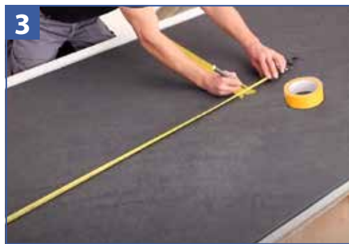
Reporter les cotes sur le panneau (Astuce: utiliser un adhésif de masquage léger pour reporter vos côtes).
