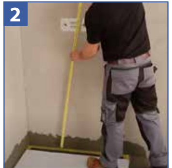
2 Relever les côtes des arrivées d'eau.
