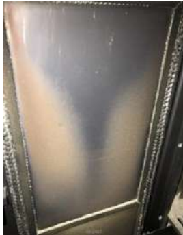
Beispiel einer verschmutzten Scheibe
