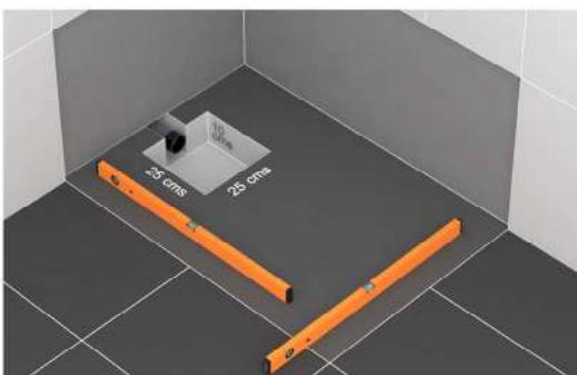
Conecte la válvula de desagüe con la bajante de la obra, asegurándose de que la válvula no queda por encima del nivel de la base de mortero. (Recomendamos no fijar la válvula a la obra para facilitar la posterior conexión con el plato)
