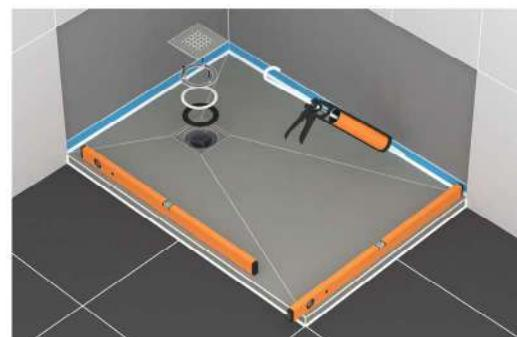
Colocar el plato perfectamente nivelado, haciendo coincidir el hueco del desague con la válvula previamente instalada. Aplicar un cordón de masilla de silicona neutra ó poliuretano para realizar el sellado del plato.
