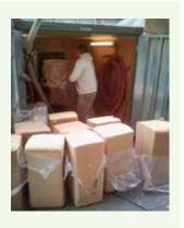
La machine et les ballots d'isolant restent à l'extérieur. La machine est contrôlée à l'aide d'une télécommande, toutes les cavités sont isolées, sans tassement, sans ponts thermiques, et sans avoir à porter les ballots dans le bâtiment.
