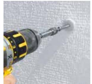
De faibles charges comme une lampe ou une boîte aux lettres peuvent être fixées dans l'isolant avec des chevilles à isolant. Le trou pour les chevilles spirales doit être prépercé avec une mèche à bois de diamètre 8 mm. Le montage doit être effectué sans risque d'infiltration d'eau dans l'isolant. Il est recommandé d'utiliser une bande d'étanchéité et un mastic-colle élastique pour assurer l'étanchéité des joints.
