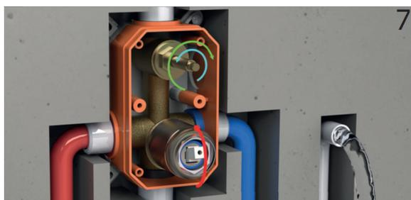
7 Ouvrir l'arrivée d'eau. Ouvrir les robinets et vérifier l'absence de fuite au niveau de l'installation. Fermer le robinet et laisser sous pression entre 24 et 48h pour vérifier l'absence de fuite.
