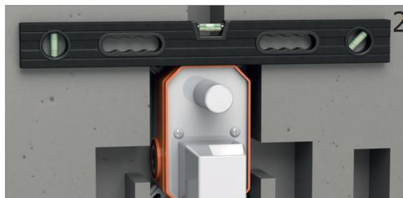
2 Placer le boîtier d'encastrement. Vérifier qu'il soit de niveau.
