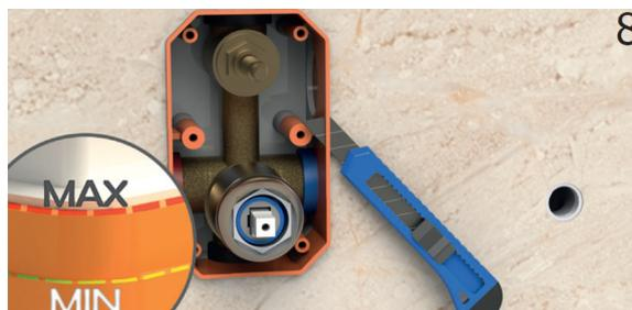
8 Re-fermer l'arrivée d'eau. Recouvrir votre mur final à l'aide d'un cutter.
