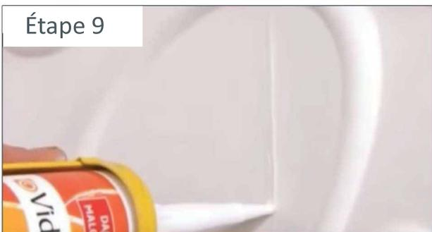
Pour une meilleure finition, nous recommandons d'appliquer un joint acrylique souple entre les plaques. (Une pose sans joint est possible)
