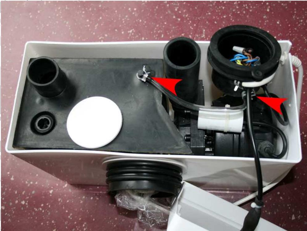
Vérifiez qu'il n'y a pas de liquide dans le caoutchouc ni dans le pressostat. Si c'est le cas séchez les.
