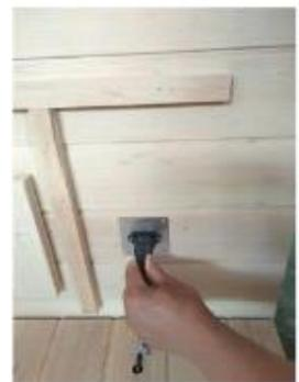
Verbinden Sie den Stecker der Bodenplatte mit der rechten Rückwand.
