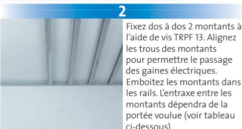
2 Fixez dos à dos 2 montants à l'aide de vis TRPF 13. Alignez les trous des montants pour permettre le passage des gaines électriques. Emboitez les montants dans les rails. L'entraxe entre les montants dépendra de la portée voulue (voir tableau ci-dessous). Finissez avec un montant vissé sur le dernier mur.
