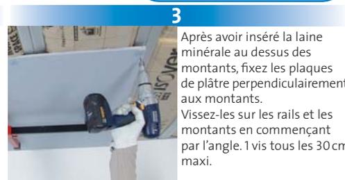
3 Après avoir inséré la laine minérale au dessus des montants, fixez les plaques de plâtre perpendiculairement aux montants. Vissez-les sur les rails et les montants en commençant par l'angle. 1 vis tous les 30 cm maxi.
