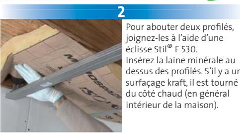
2 Pour abouter deux profilés, joignez-les à l'aide d'une éclisse Stil® F 530. Insérez la laine minérale au dessus des profilés. S'il y a un surfaçage kraft, il est tourné du côté chaud (en général intérieur de la maison).
