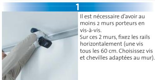
1 Il est nécessaire d'avoir au moins 2 murs porteurs en vis-à-vis. Sur ces 2 murs, fixez les rails horizontalement (une vis tous les 60 cm. Choisissez vis et chevilles adaptées au mur).
