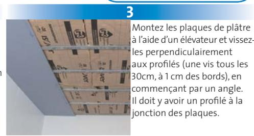
3 Montez les plaques de plâtre à l'aide d'un élévateur et vissez-les perpendiculairement aux profilés (une vis tous les 30cm, à 1 cm des bords), en commençant par un angle. Il doit y avoir un profilé à la jonction des plaques.
