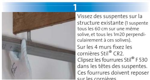
1 Vissez des suspentes sur la structure existante (1 suspente tous les 60 cm sur une même solive, et tous les 1m20 perpendiculairement à ces solives). Sur les 4 murs fixez les cornières Stil® CR2. Clipsez les fourrures Stil® F 530 dans les têtes des suspentes. Ces fourrures doivent reposer sur les cornières.
