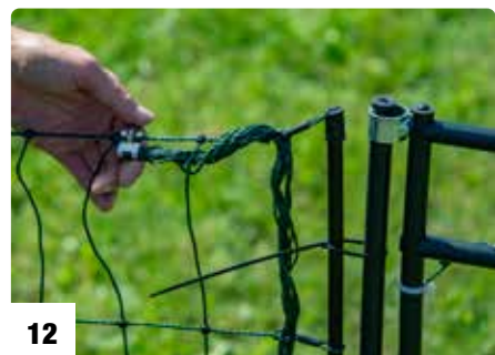
Netzverbindungsklemme außerhalb des Durchgangsbereiches befestigen Attach the net connection clamp outside the passage area Fixez la pince de connexion du filet à l'extérieur de la porte
