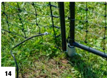
Anschluss des Erdkabels an den Netzen links und rechts vom Tor Connecting the underground cable to the nets on the left and right of the gate Raccordez le câble souterrain au filet à gauche et à droite de la porte
