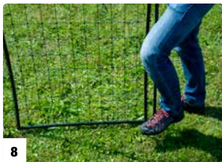
Eintreten des Torpfahls, um den das Tor schwenkt Pushing the gate post into the ground around which the gate pivots Enfoncez dans le sol le poteau pivotant du portail
