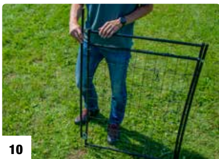
Positionierung des Anschlagpfahls Positioning of the stop post Positionnement du portail fermé
