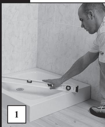
Suivre à la lettre les instructions de montage du fabricant. Avant l'installation, vérifier l'horizontalité du receveur et l'étanchéité entre le receveur et le carrelage. Les murs devant être carrelés là où les profilés muraux seront fixés.
