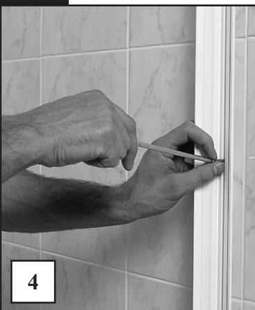
Percer en utilisant une mèche de 6 mm, puis cheviller et visser à l'aide des vis No. 5 x 40 mm fournies.
