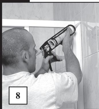
Siliconer aux jointures verticales à l'intérieur et à l'extérieur.
