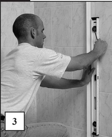
Mette les profilés muraux à environ 15 mm du rebord extérieur du receveur. Vérifier qu'ils soient à angle droit par rapport au receveur et marquer leurs positions à travers les trous prépercés.
