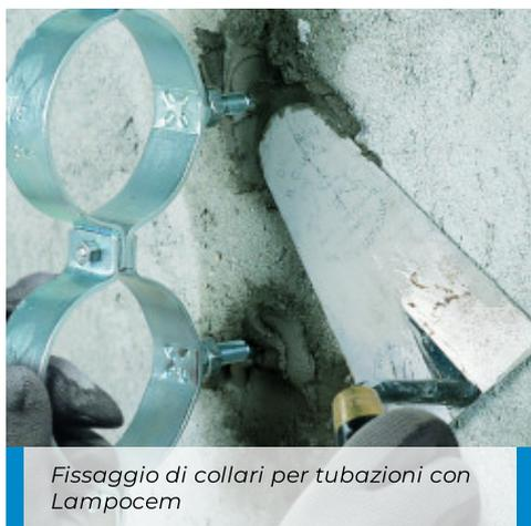
*Fissaggio di collari per tubazioni con Lampocem*
