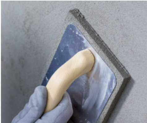
Frattazzatura di Planitop Rasa & Ripara R4
