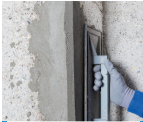
Lisciatura di Planitop Rasa & Ripara R4 con frattazzo
