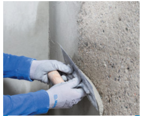
Applicazione a spatola di Planitop Rasa & Ripara R4
