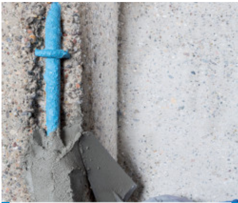
Applicazione a cazzuola di Planitop Rasa & Ripara R4
