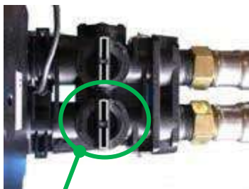
1 Ouvrir la vanne d'arrivée d'eau
